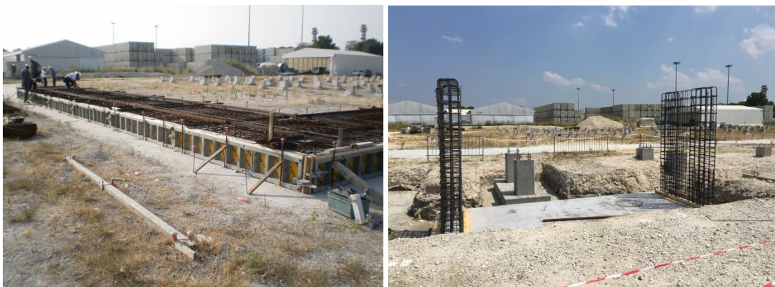
Foto: cantiere nuova torcia
